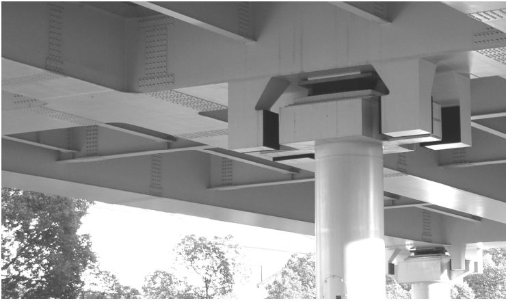
図5 ガイドウェイ・バス大曾根駅の免振構造（名古屋市大曾根、筆者撮影） 上の台と柱の間に見える黒い板が免振バネ。脱落防止の枠が囲んでいる。
